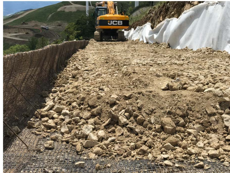
TERRE RINFORZATE: FASI DI INSTALLAZIONE DEL PAVIDRAIN
