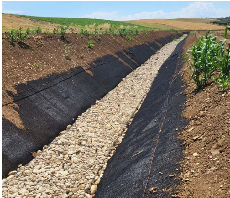
FASI DI INSTALLAZIONE DEL TRENCHMAT: FOSSO DI GUARDIA LARGO
