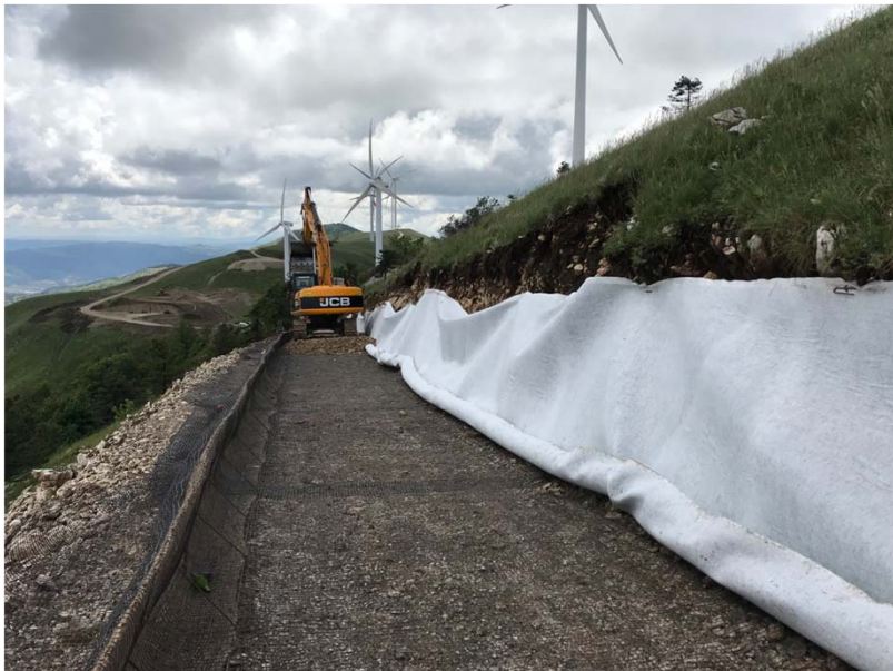
TERRE RINFORZATE: FASI DI INSTALLAZIONE DEL PAVIDRAIN
