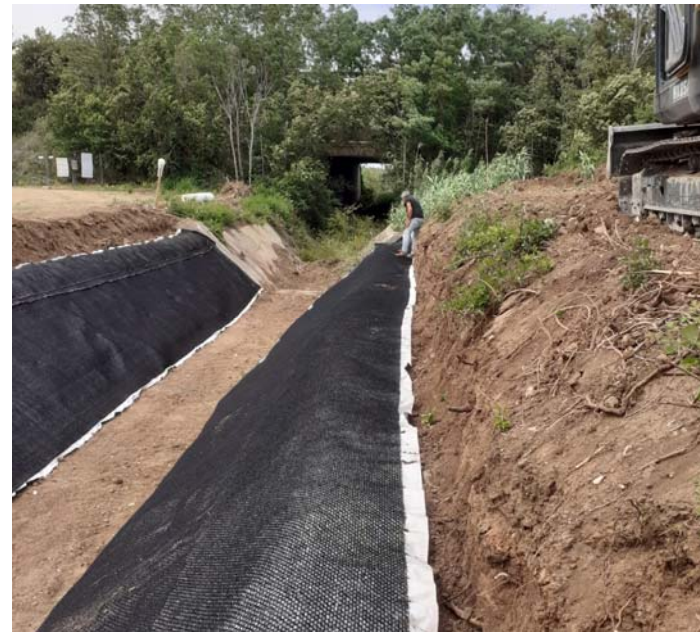
FASI DI INSTALLAZIONE DEL TRENCHMAT: FOSSO DI GUARDIA LARGO
