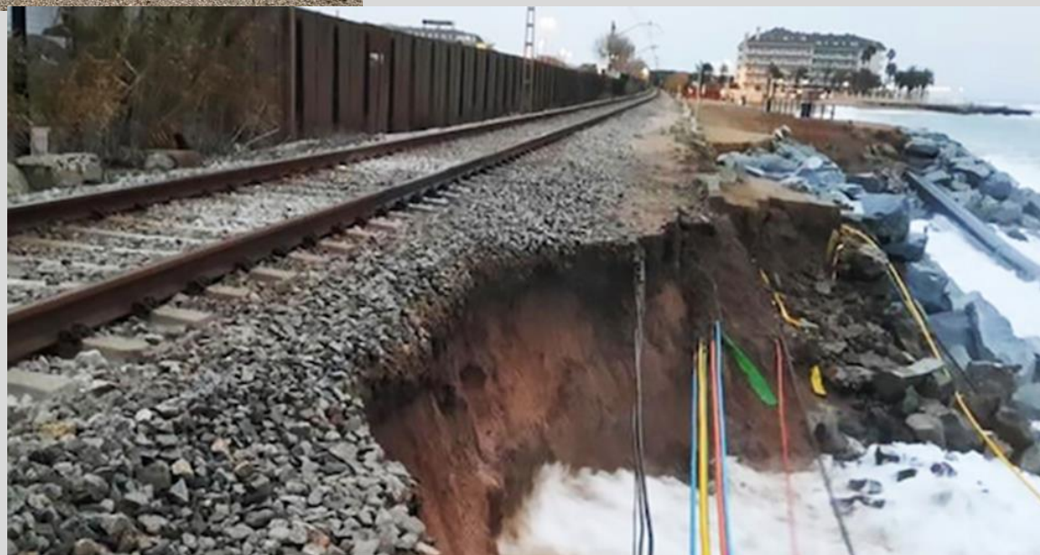
linea ferroviaria in Cataluña
